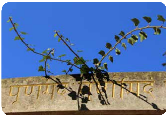
Der Efeu versucht bereits, über die mit einer Sanskrit-Inschrift verzierte Mauerkrone zu fliehen
